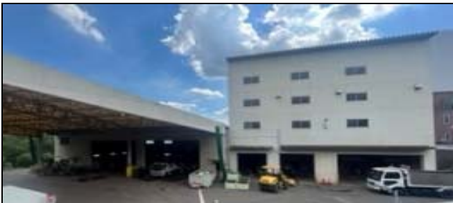
粗大ごみ処理施設の全景
